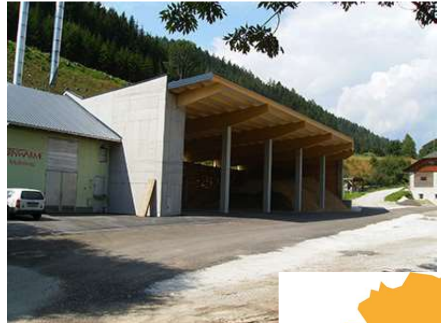
Source: Fernwärme Möderbrugg
