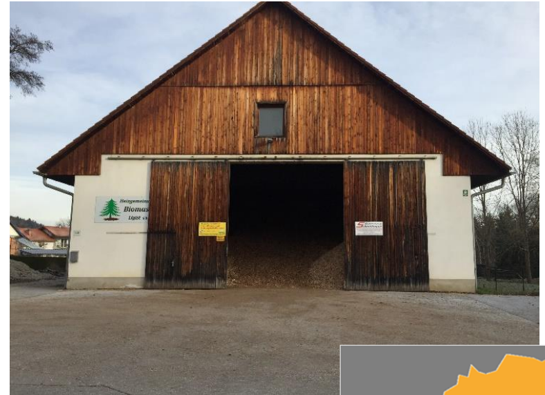
Source: Biomasse Heizgemeinschaft Ligest
