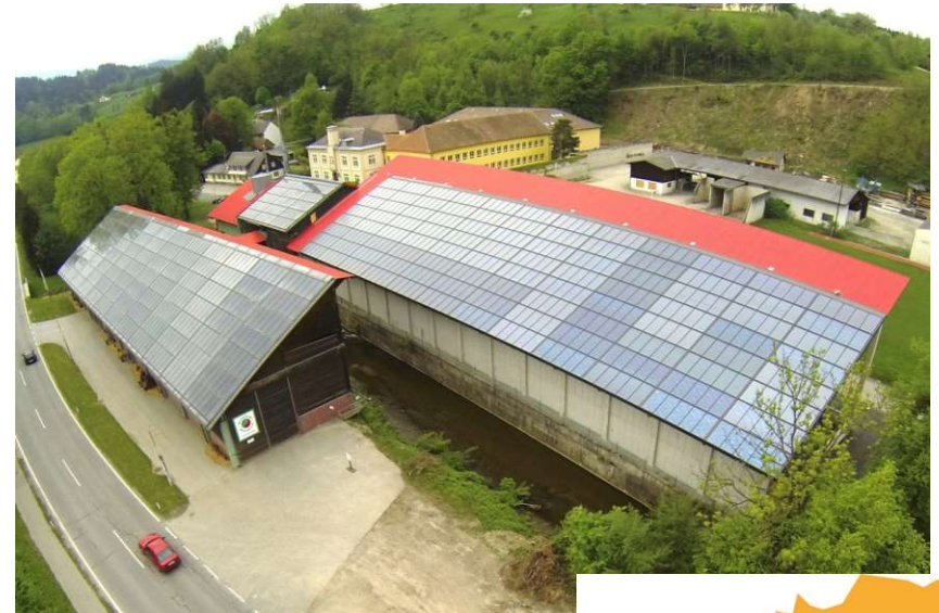
Source: Nahwärme Eibiswald
