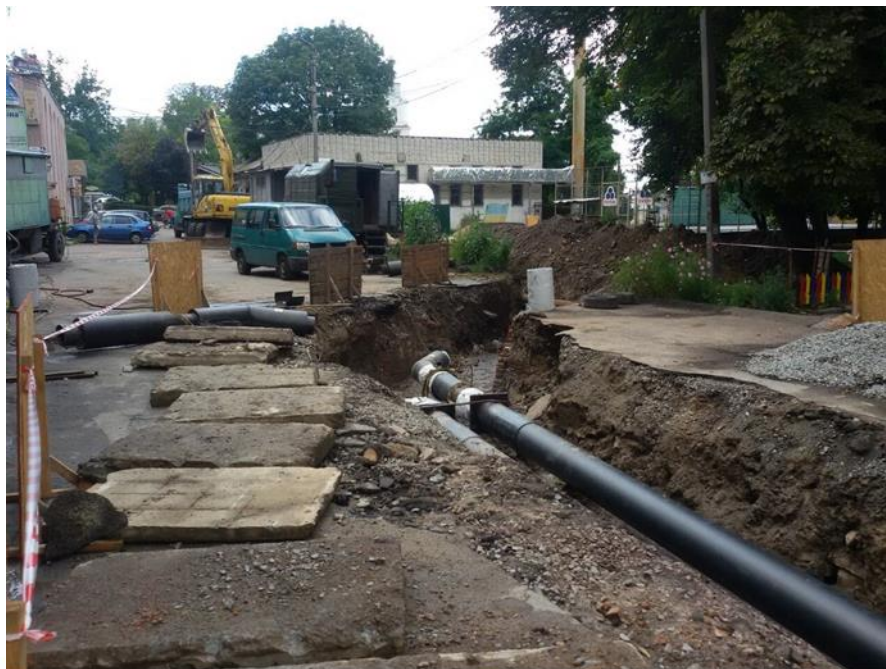
Реконструкція теплових мереж від т. 943 по майдану Соборному до т. 783 по вул. Перемоги, 1 в м. Житомирі (коригування) Вартість : 4 763 396 грн L= 485 м; діаметр 273/400 мм Виконання: 80%
