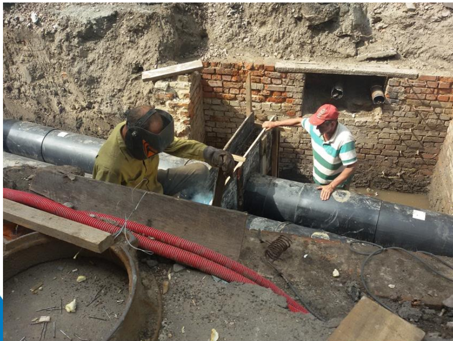
Реконструкція теплових мереж від ТК-23 по майдану Корольова, 7 до т. 135 по майдану Корольова, 6 в м. Житомирі (коригування) Вартість : 1 656 090 грн L= 142 м; діаметр 325/450 мм Виконання: 80%
