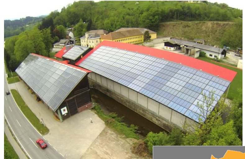
Quelle: Nahwärme Eibiswald
