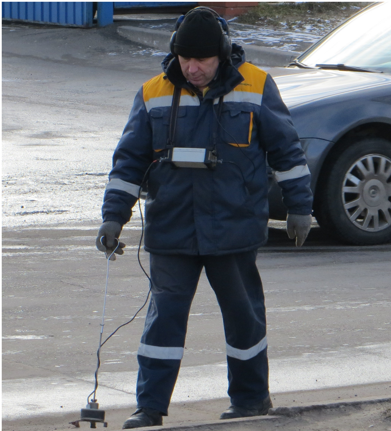
поиск утечки теплоносителя прибором А10-Т
