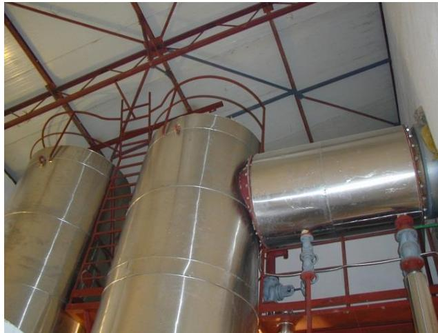
Dvopromajni vertikalni razmenjivač topline
