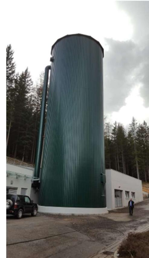
Energie im Puffer in kWh = Pufferinhalt in m<sup>3</sup> \* c \* Temperaturspreizung
