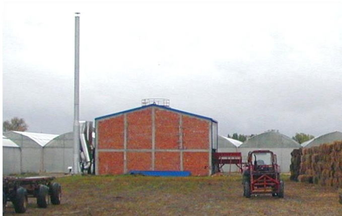
Pogled na kotlarnicu i platenik
