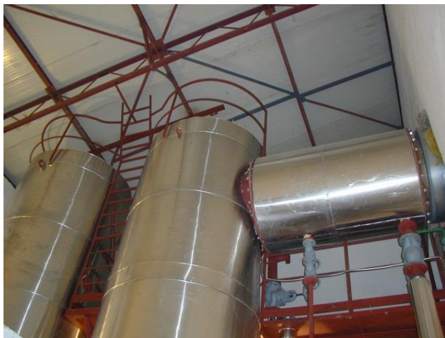
Dvopromajni vertikalni razmenjivač toplote
