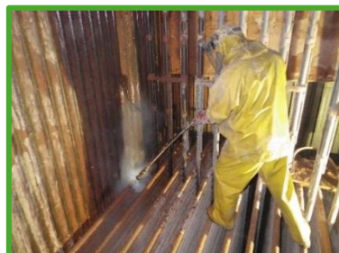
Čištění tlakovou vodou
