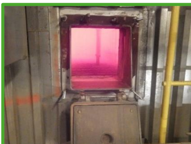
Čištění mikrovýbuchy uvnitř provozovaného kotle
