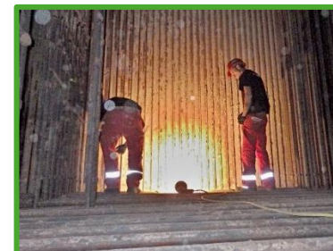
Čištění mikrovýbuchy uvnitř odstaveného kotle
