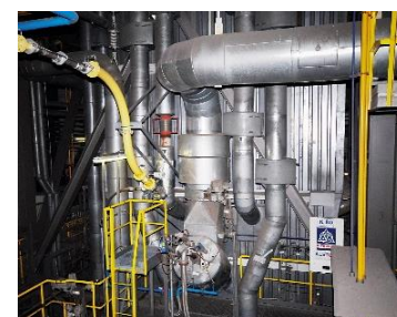
Sekundární vzduch – vstup do kotle
