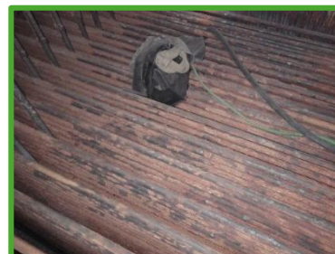
Čištění pískováním
