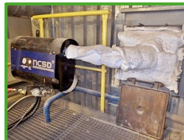
Akustické čištění mikrovýbuchy vyvíjenými v externím zařízení
